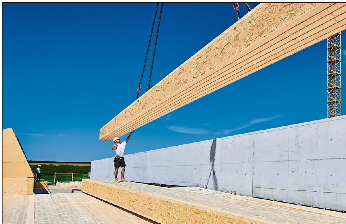
Die Holzbauteile sind einfach und schnell zu montieren.
