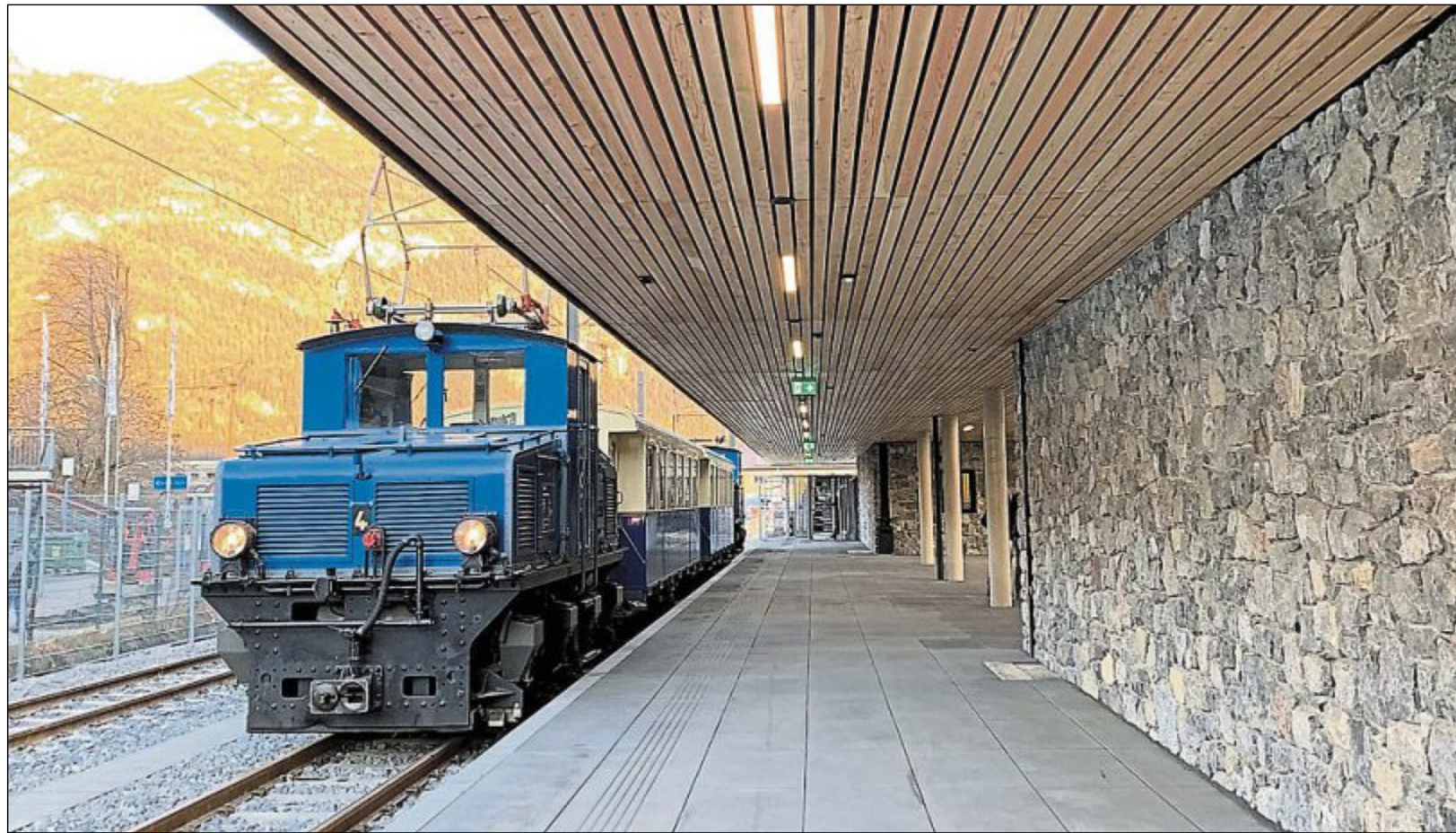
Dem Komfort der Fahrgäste dient ein überdachter Wartebereich zu den Gleisen hin.
