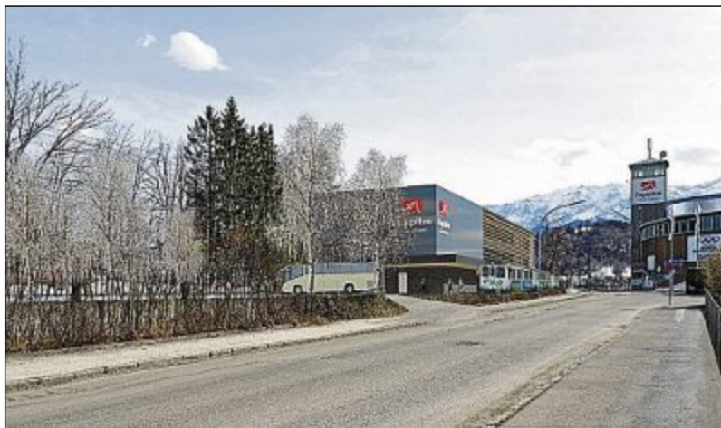
Blick auf das neue Bauwerk.
