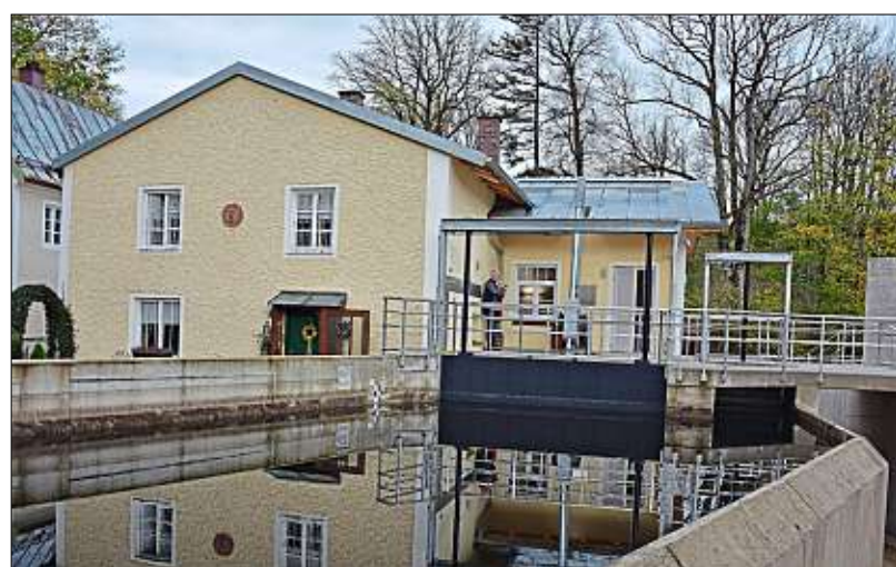
Zusammengenommen leisten die sieben Traunkraftwerke in Traunstein aktuell rund 5 Millionen Kilowattstunden Strom aus Wasserkraft, etwa eine Mio bis 1,5 Mio Kilowattstunden mehr als vor Ausbau und Ertüchtigung.
