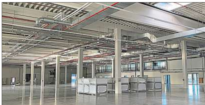
Die Produktionshalle: Darin befinden sich die Montage, die Verpackung, der Versand sowie auch die Elektroprüfung.
